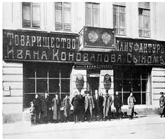
Контора и торговый склад Товарищества в Коканде
