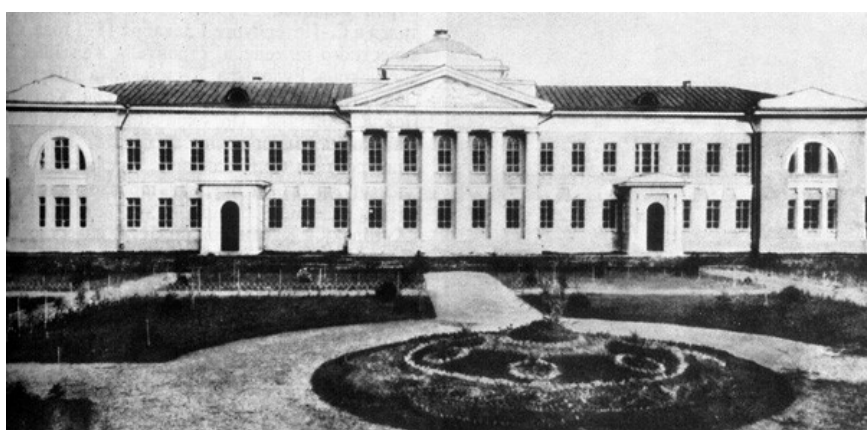
Главный больничный корпус при фабриках в Бонячках
